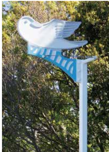
モニュメント：W635×H512 アルミ鋳物、フッ素樹脂塗装 支柱：GLH2200 mm SUS 角柱
