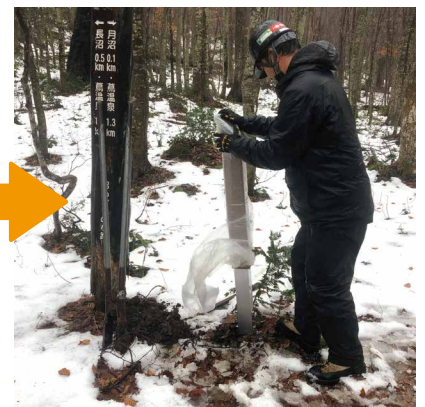
手回してスクリューを打ち込み
