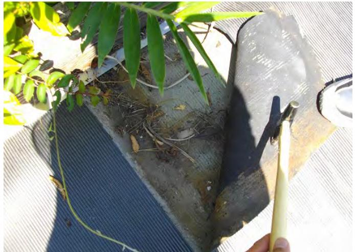
雨水が入り込んで腐朽が進行している……
