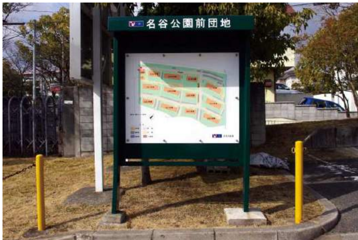
板面貼替 印刷：(表示面)スーパーカラーR+ABコート (団地名)スーパーカラーR+カッティングシート
