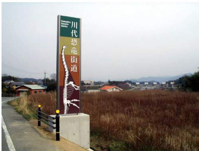
本体：アルミ押出形材 印刷：ハイブリッドカラー印刷
