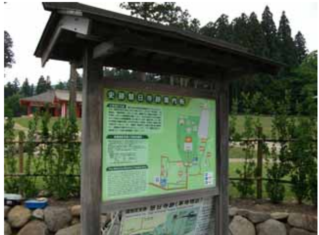
修繕後 YY-0009 表示板サイズ:1400×1000 mm 表示方法:スーパーカラーR印刷 本体素材:木材
