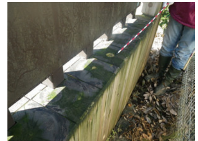
木材の腐朽・カビ
