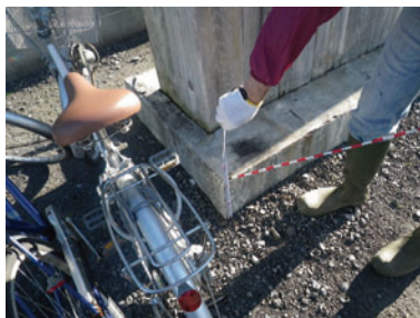
地際部の足がかり・基礎コンクリート露出
